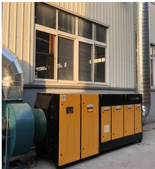
图 7 UV 光氧催化+活性炭吸附装置+17m 高排气筒 P1
