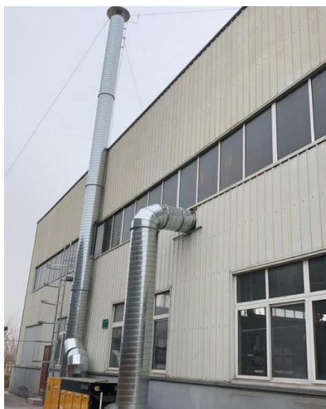
图 7 UV 光氧催化+活性炭吸附装置+17m 高排气筒 P1
