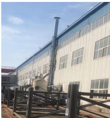
喷漆晾干排气筒 P2（DA002）
