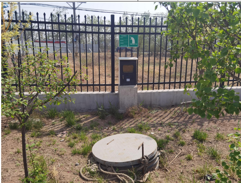
废水标志牌及废水采样口
