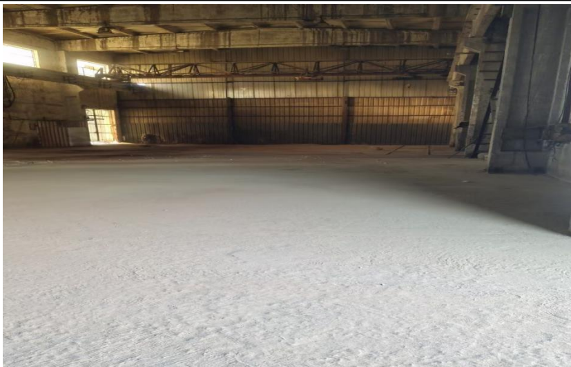
图 4 厂房现状照片
