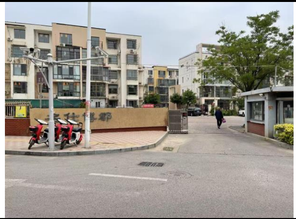
北侧居民楼-名仕博郡
