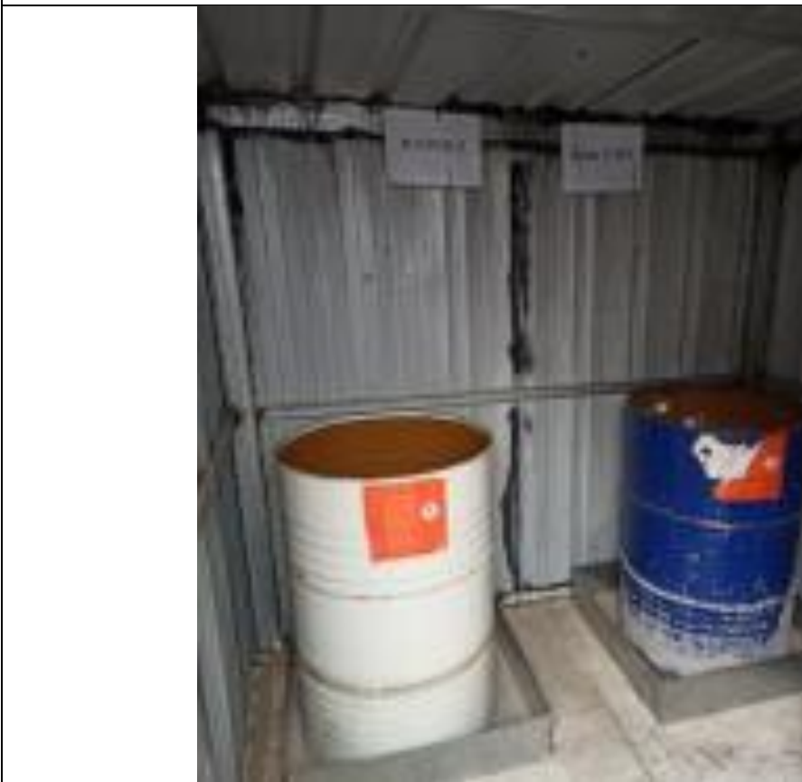
危险废物暂存间（内）
