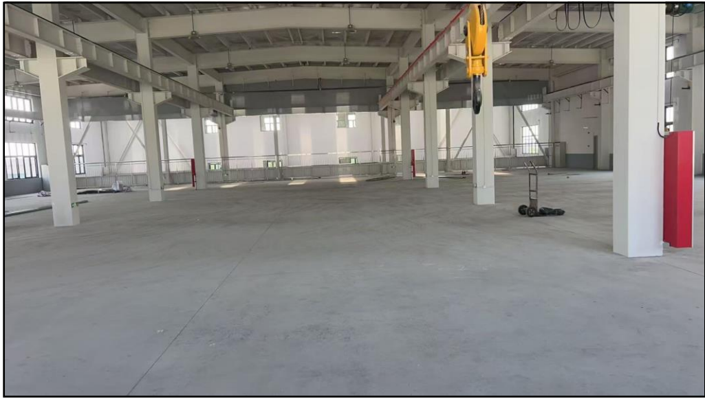
图 2-9 现有厂区内新建车间（已建成）照片
