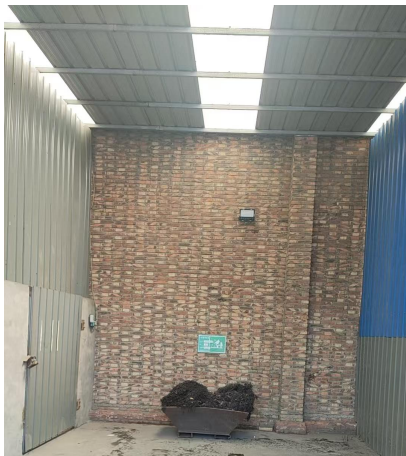
一般固废暂存处
