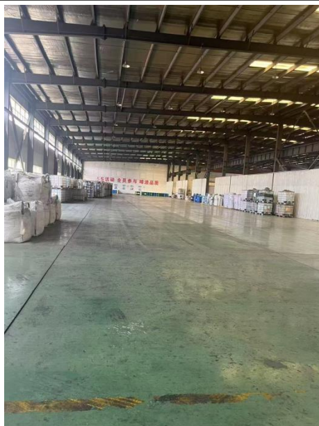
图 15 租赁厂区现状
